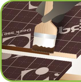
Depois de cortar o contraplacado, proteja as bordas selando-as com tinta, por exemplo, TEKNOS Teknol JRL (Finlândia) para evitar a entrada de humidade.
