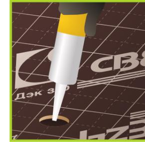
用砂樹脂構成的黏合劑填滿所有孔，在安裝過程中完成此過程，以防止濕氣 (膨脹) 滲透。
